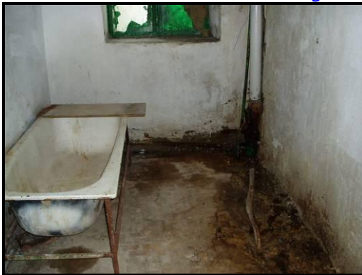
Leidingen verroest en afvoer kapot
